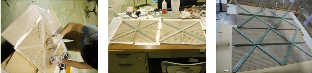
図 3.15 PCB に補強材を接着している様子
